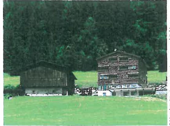
Bildnachweis: stuppner-unterweger architektur
