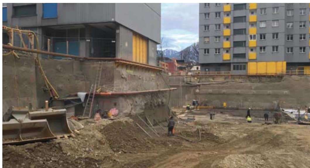
Eine umfassende Absicherung der Baugrube und der Schutz umliegender Gebäude gehört zu den wesentlichen Aufgaben von GeotechnikerInnen. Foto: Bienenstraße/© 3P Geotechnik
