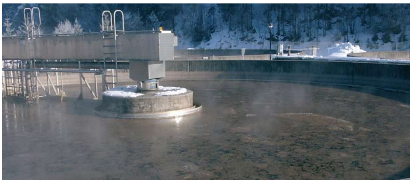
ZiviltechnikerInnen überprüfen unter anderem regelmäßig Kläranlagen.
